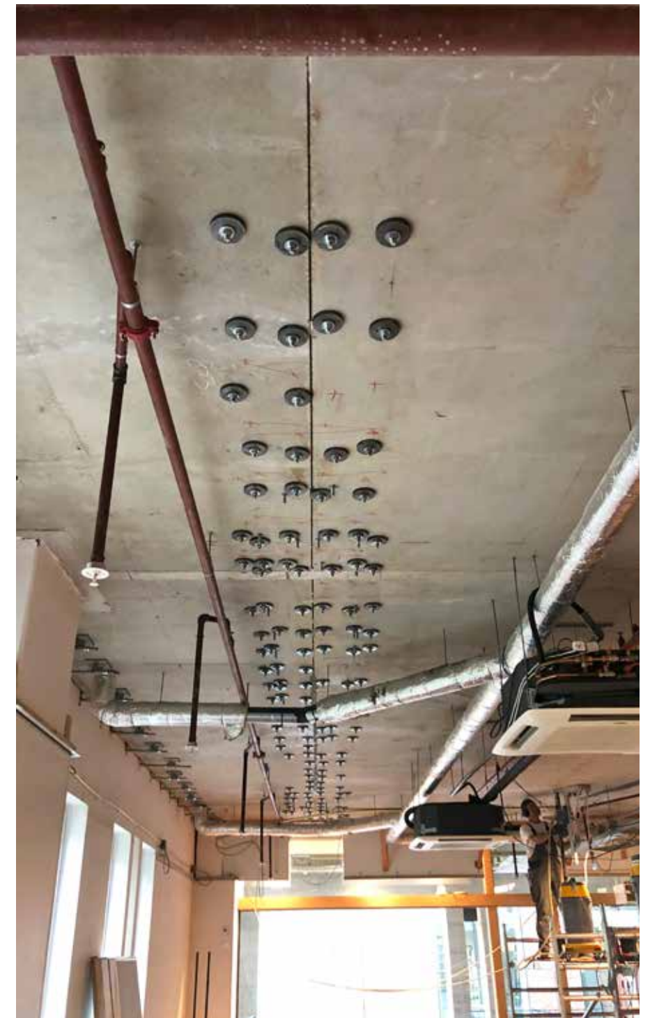
Diverse nieuwe en bestaande gebouwen zijn reeds met het constructieve anker constructief versterkt.
